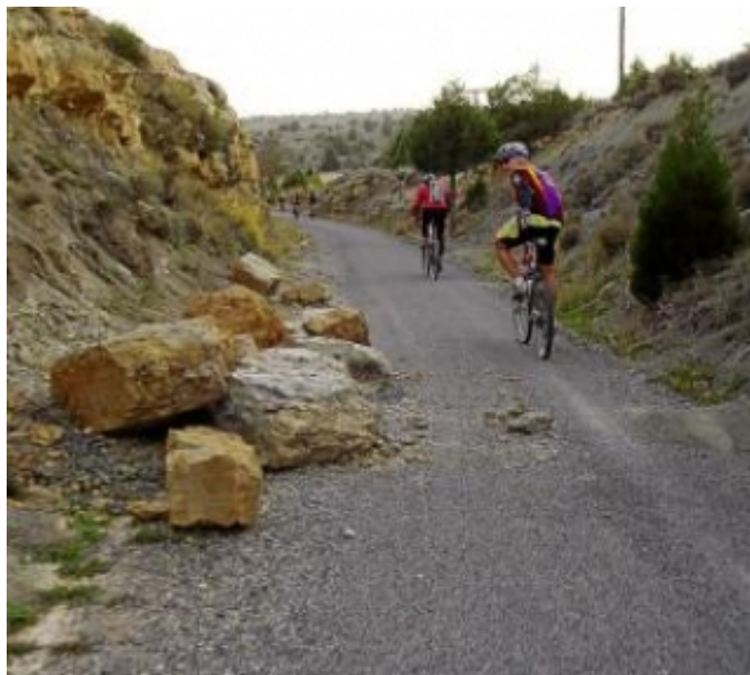
Rocas desprendidas en el tramo de La Puebla de Valverde.. marcelino vivas
